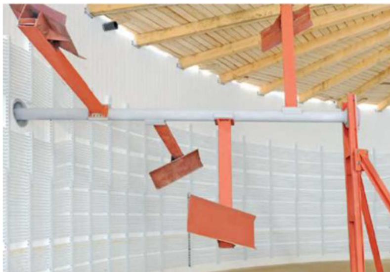
Figure 9 : Système d'agitation : paddelgigant (Source : Agrikomp)
